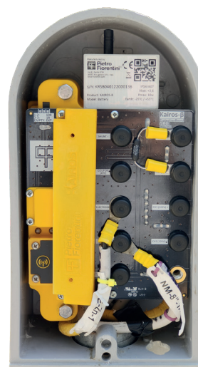
Figura 3 Instalación de Kairos
