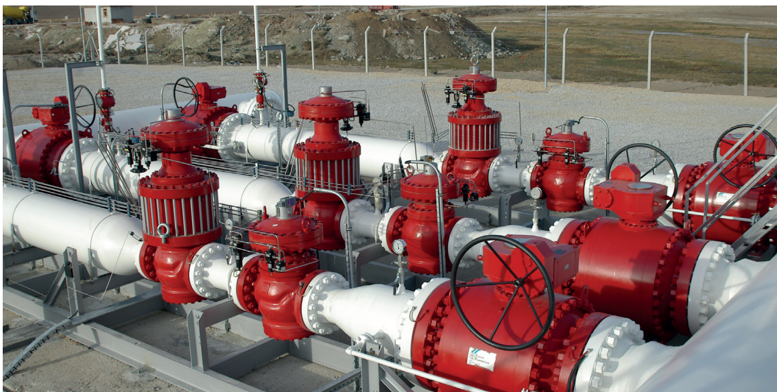
Reflux 819/FO/DB (рабочий регулятор) + Reflux 819 (регулятор-монитор) | газораспределительный пункт на входе в городскую сеть, регион EMEA
